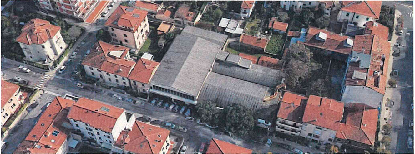
1. Vista area ex-concessionaria Via S. Ciampi
